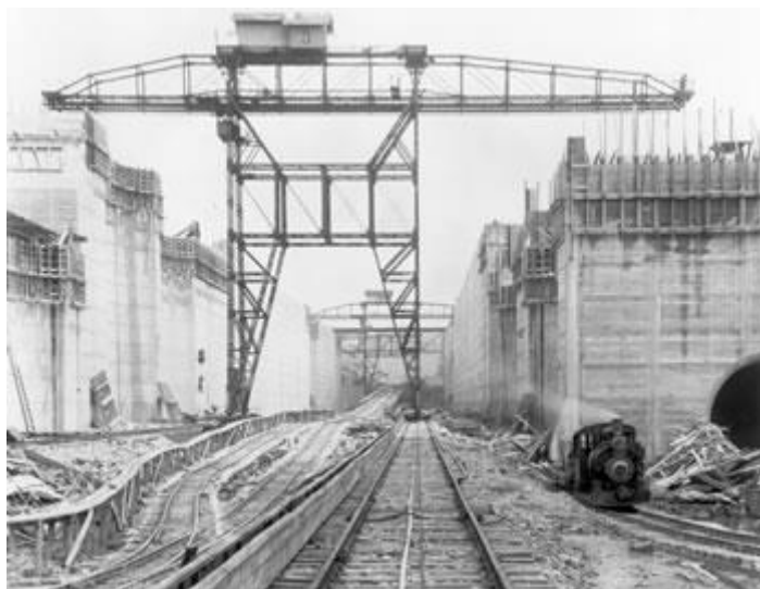
Figura 2: Eclusas em construção
