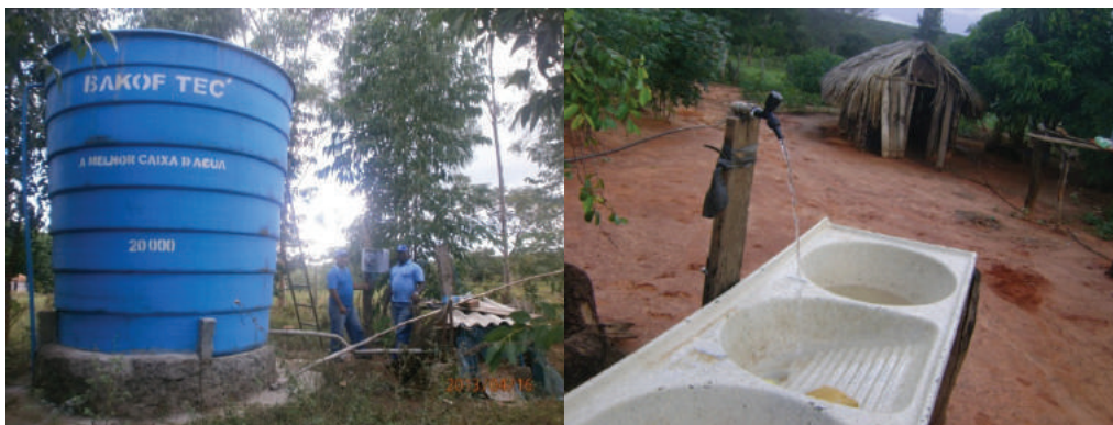
Foto 2 – Instalação de reservatório de 20m e automação do sistema na Comunidade de Varginha
