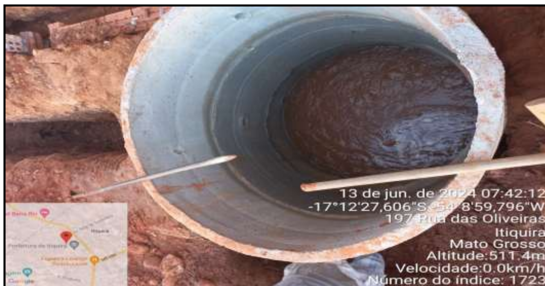
Figura 3: Foto de uma fossa negra em construção
